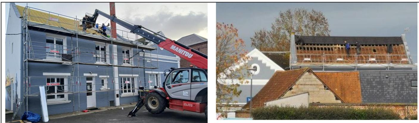
Rénovation complète des toitures avant et arrière de la Mairie : remplacement des ardoises, pose d'une sous-toiture, travaux d'étanchéité, renforcement d'une pièce de charpente, démontage d'une cheminée.
