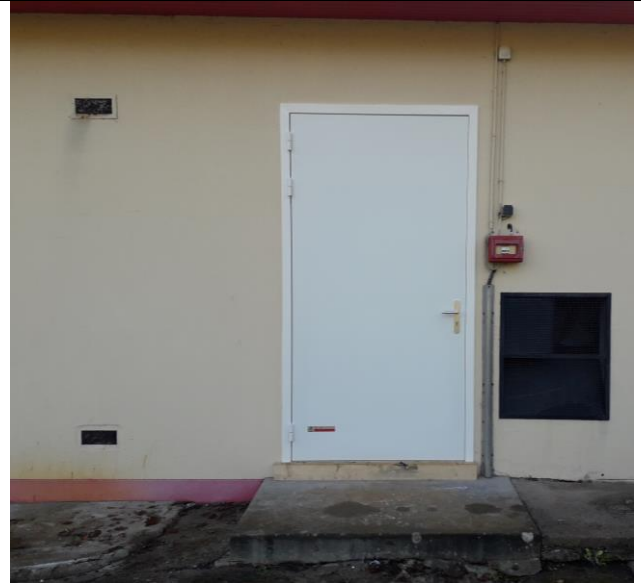
Après : porte métallique
